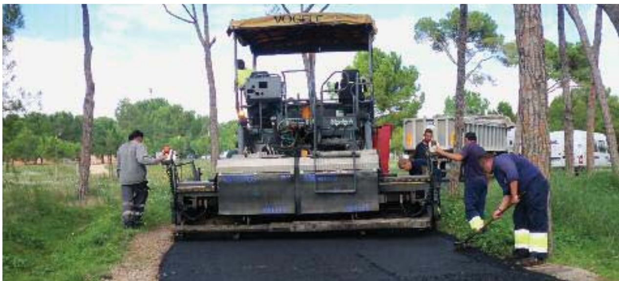
Asfaltat del camí d'accés a la cripta de la Colònia Güell
