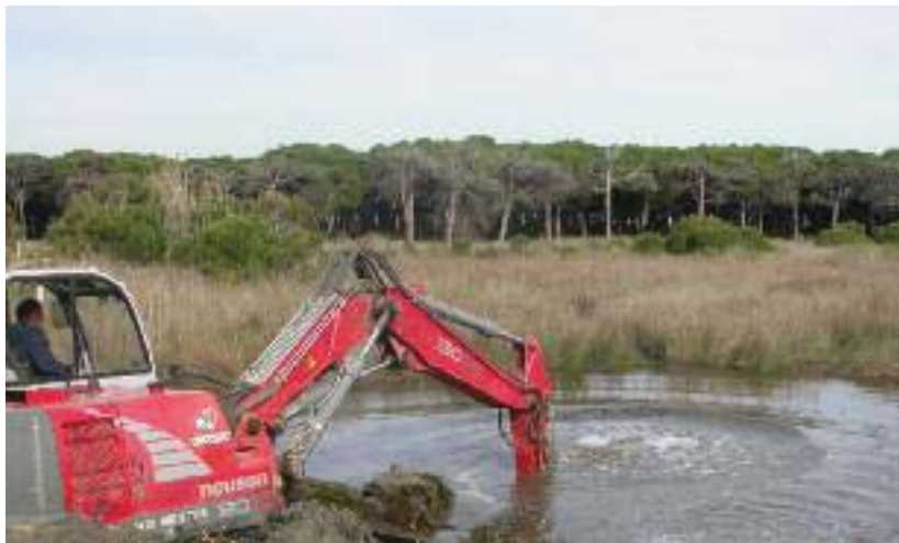
Excavació d'una bassa de nova creació per la generació d'hàbitats adients als peixos larívors com ara el Fartet ( Aphanius iberus ) per al control biològic de les larves dels mosquits.
